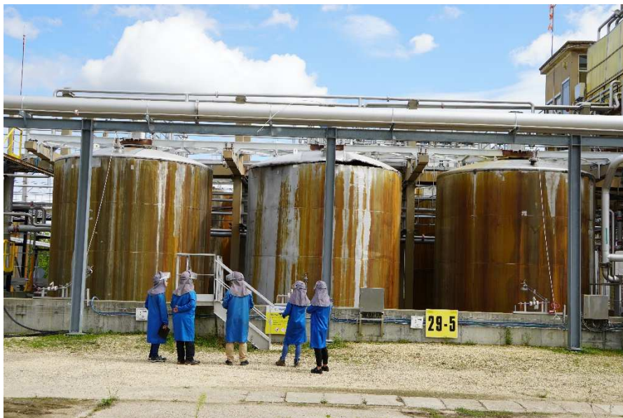
Photo 9 : Vue de la cuvette 29-5 après l'explosion
