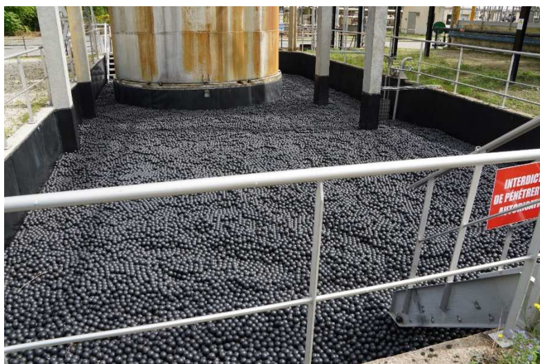
Photo 10 : Cuvette de rétention avec billes PEHD permettant de limiter l'évaporation des vapeurs acides
