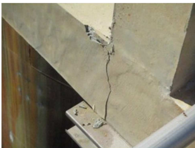
Photo 5 : Portique béton fissuré
