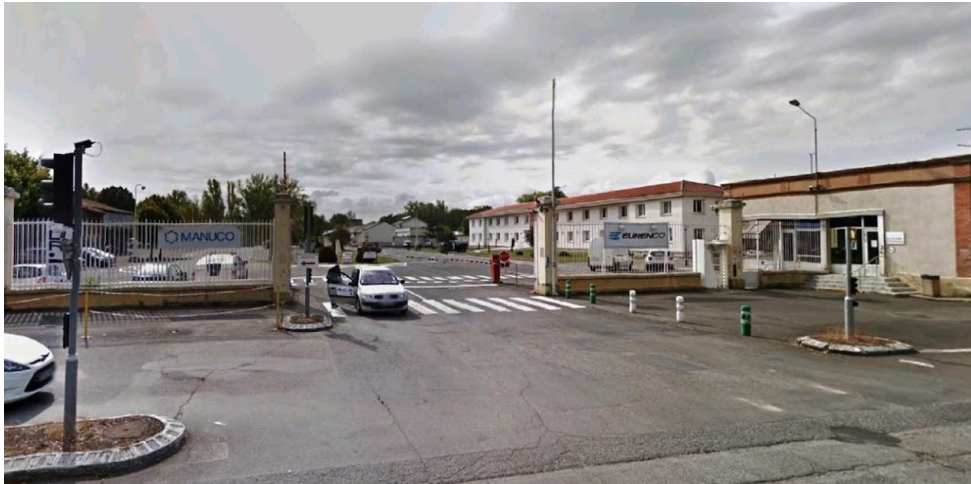
Figure 1 : Vue de l'entrée de la plateforme MANUCO EURENCO DURLIN (Source BEA-RI)
