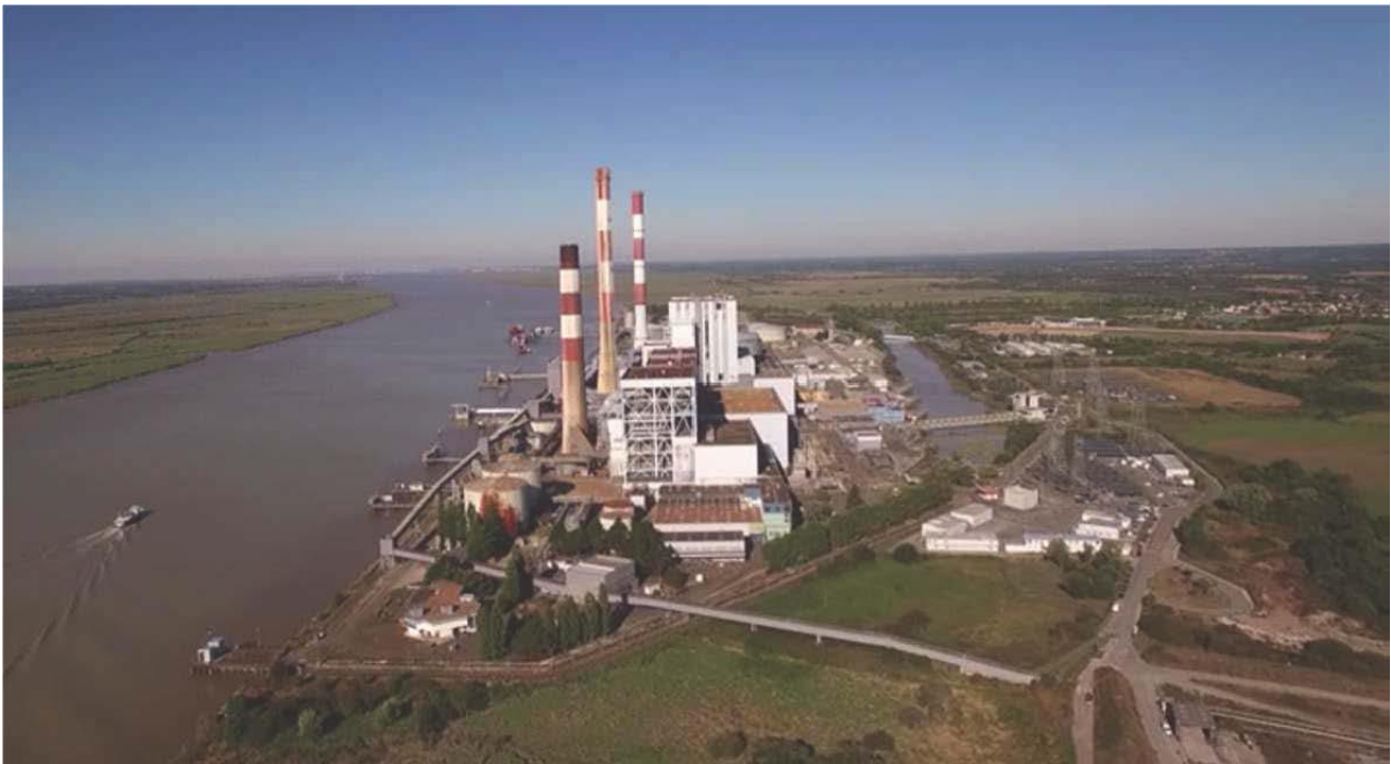
Figure 2 : Vue aérienne de la centrale de Cordemais (source : dossier)
