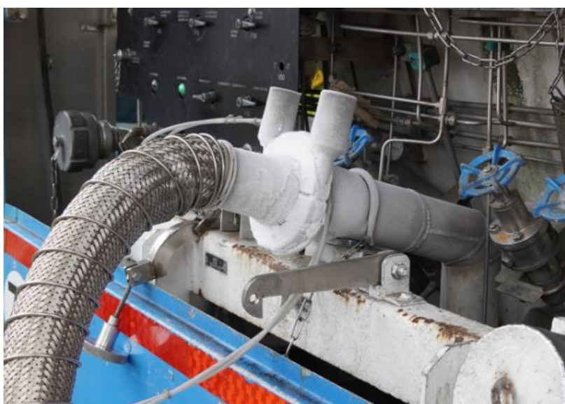
Figure 13 : Givrage du raccord du flexible de dépotage / remplissage
