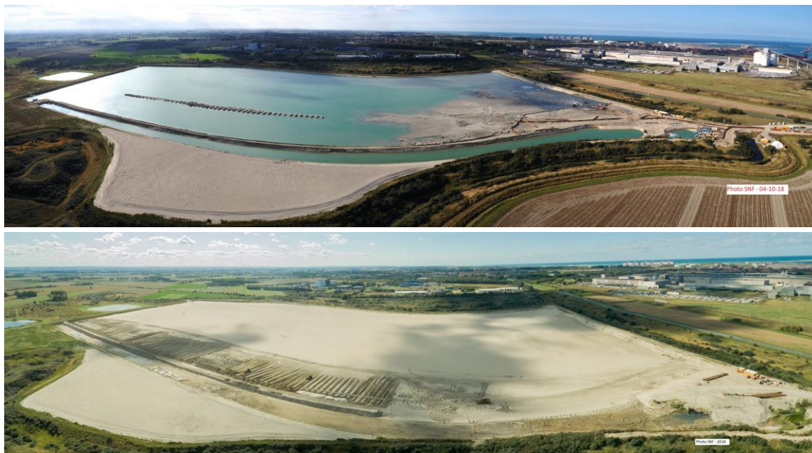
Figure 2 : Photos panoramiques de l'installation de transit, en exploitation et vidée, transmises aux rapporteurs suite à leur visite
