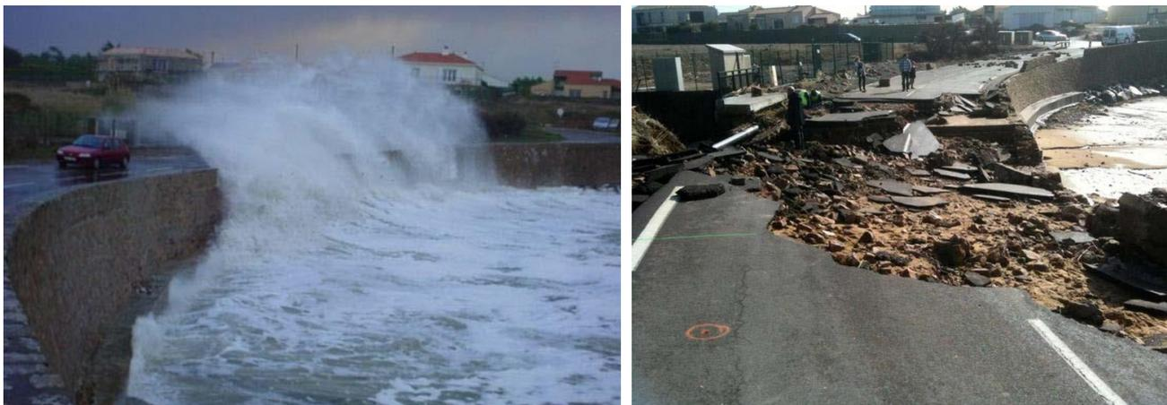
Figure 5 : Photographies illustrant la violence de la tempête Xynthia de 2010 et les dégâts apparus sur la route du littoral (RD 32a) au niveau de l'Anse de la Parée. (Source dossier)
