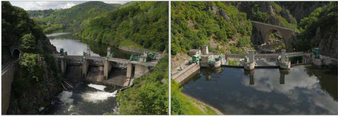
Figure 4 : Photos aériennes du barrage et de la retenue de Poutès (source : dossier)
