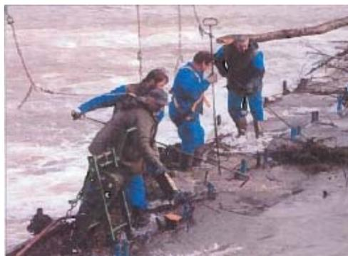
Figure 2 : fermettes abattables du barrage de Vaux (source dossier)
