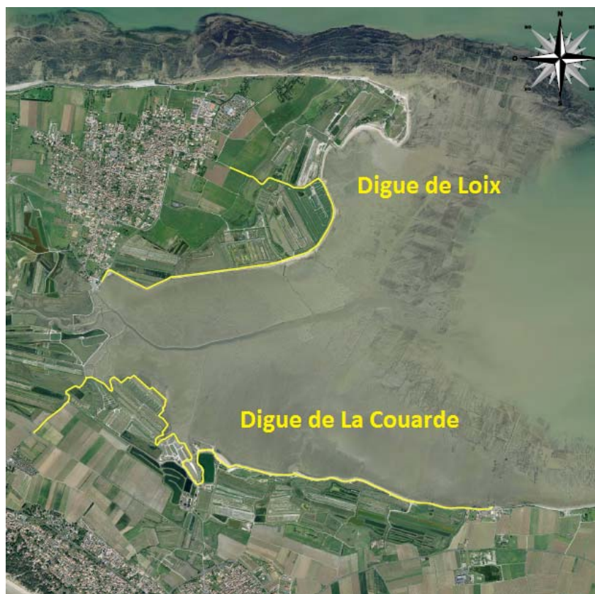
Figure 5 : Carte de situation de la digue de Loix et de la digue de La Couarde. Source : DDT
