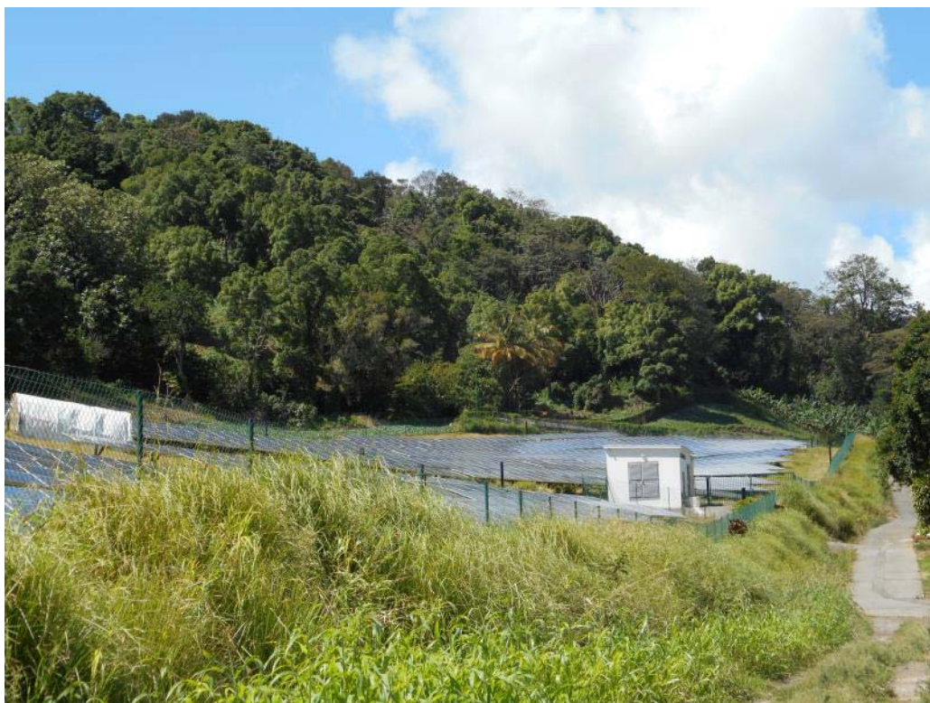
Figure 6 : Ferme photovoltaïque de Matouba (Source : "phase 1")
