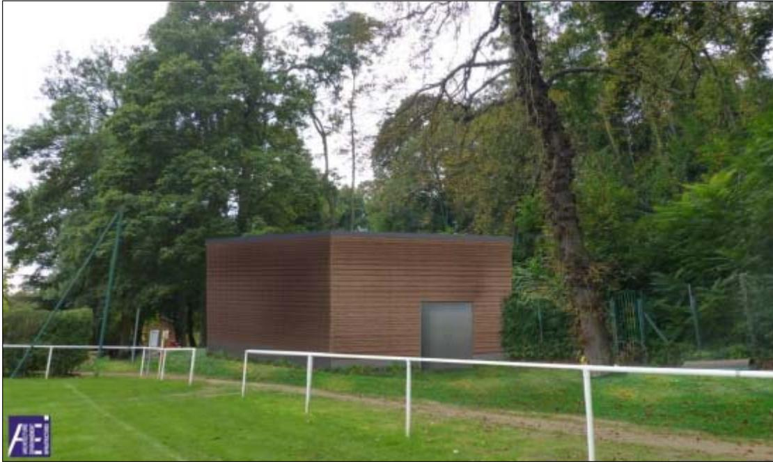
*Figure 4: Image de synthèse du futur édicule masqué dans la lisière qui accueillera le haut du puits de secours du tunnel. (Source : dossier de mise en conformité du PLU)*
