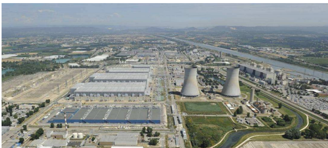
Figure 1: Vue aérienne du site depuis le sud, le canal de Donzère-Mondragon est situé à droite, la centrale EDF est le long du canal, l'usine Georges Besse comporte les bâtiments gris clair situés au milieu de la figure ainsi que les deux tours de refroidissement à droite. Au premier plan le bâtiment de l'usine Georges Besse II (mur bleu). (Source : dossier)
