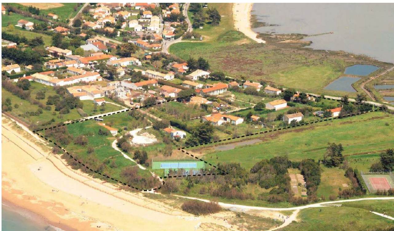
Figure 2 : vue aérienne de la zone de solidarité. Source : étude de dangers
