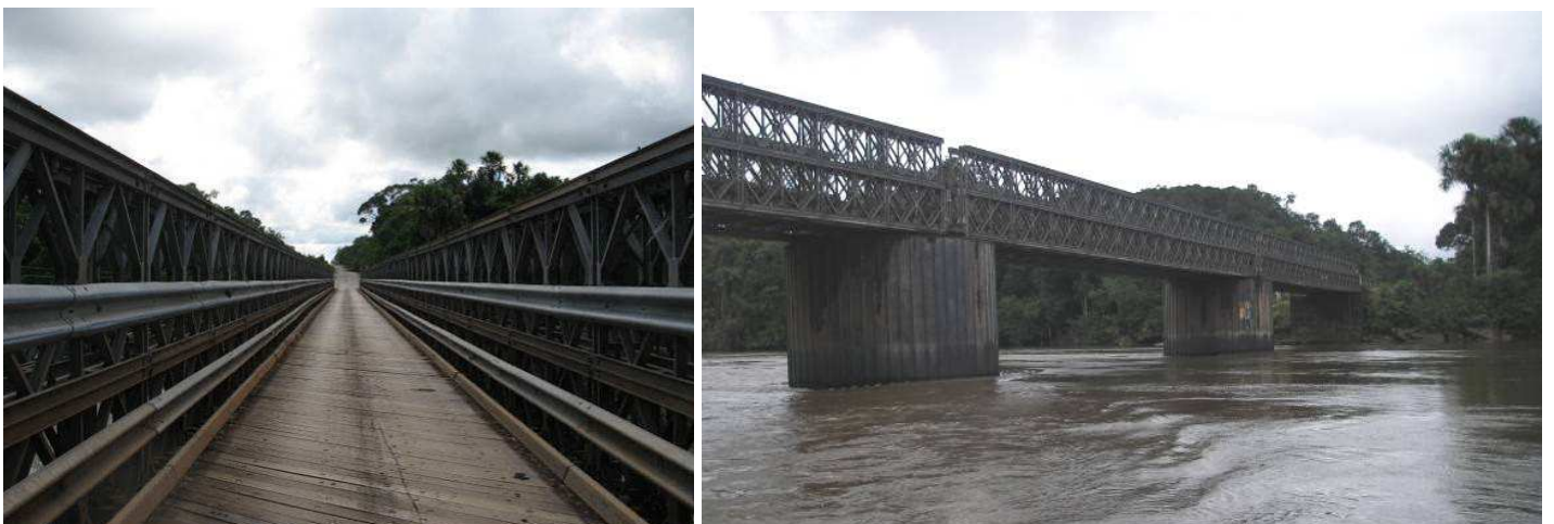
Figure 2 : photographies du pont de la RN 2 sur la Comté (source : dossier d'enquête publique)
