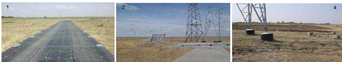
Figure 2 : Remplacement d'un pylône (source : RTE) – à gauche : mise en place de la piste ; au centre : assemblage au sol et levage des éléments ; à droite : dépose de l'ancien pylône.
