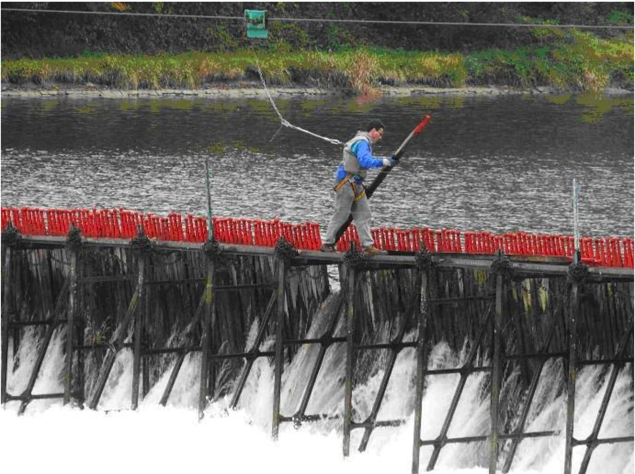
Figure 2 : barrage à aiguilles : dépose d'une aiguille (source : wikipédia)
