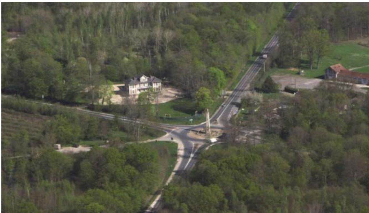
Figure 5 : vue aérienne (vers le nord) du carrefour de l'Obélisque (source : étude d'impact)
