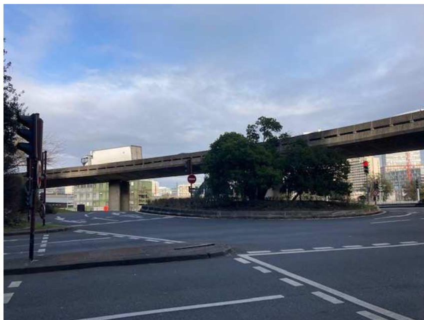
Figure 5 : Photographie du viaduc de la RN 118. Source : rapporteure.
