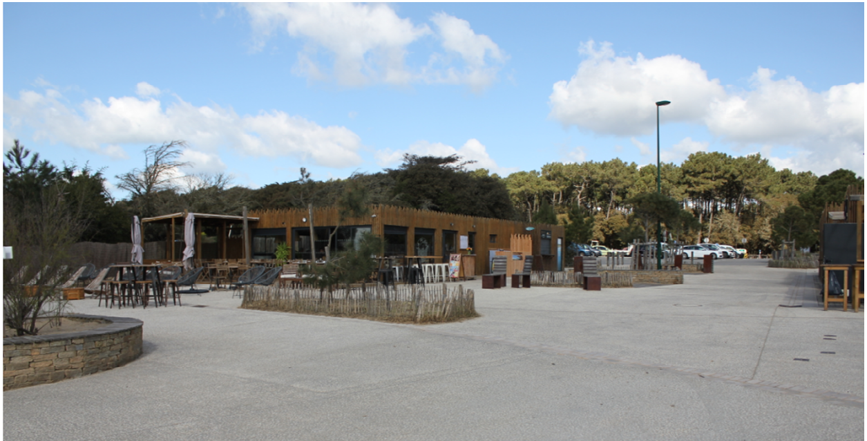
Equipements liant la plage du Veillon à l'espace de stationnement à Talmont-Saint-Hilaire (source CLN Dreal Pays de la Loire)
