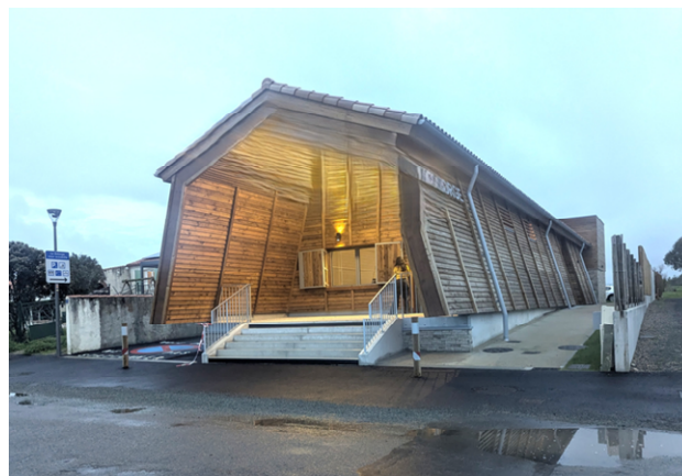
Nouveau bâtiment de la Salorge à Talmont-Saint-Hilaire (Ph.S décembre 2025)
