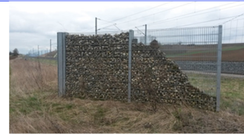
Échappatoire construit dans les règles de l'art (©Egis)
