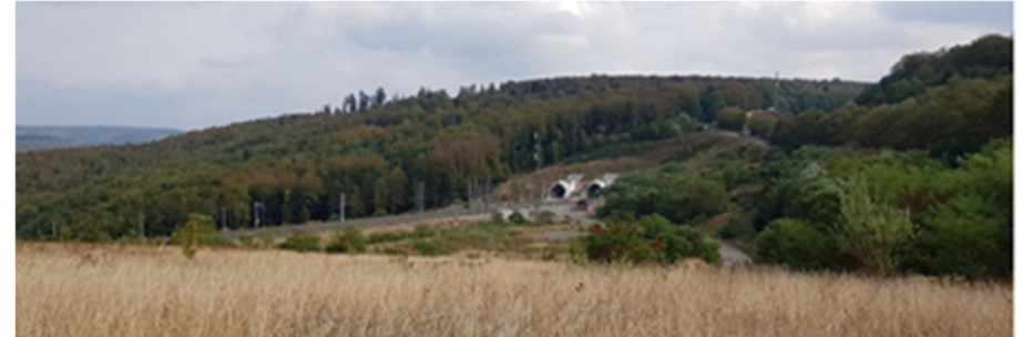
Tête ouest du tunnel de Saverne en 2020 (©Egis)
