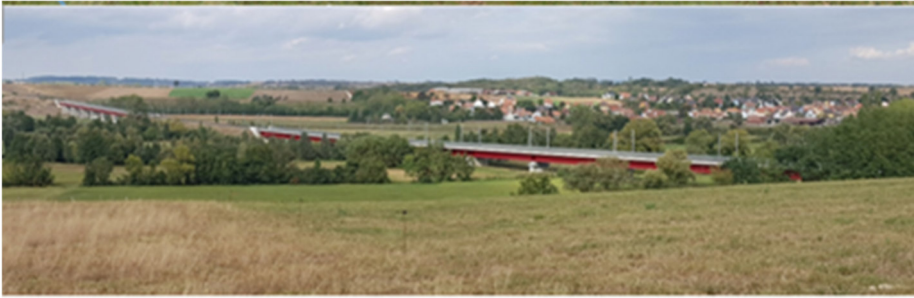
Viaduc de la Zorn en 2020 (©Egis)
