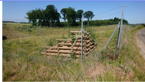
Échappatoire dont la hauteur entre le haut de l'échappatoire et la clôture est trop importante (©Egis)
