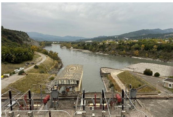
Source IGEDD - Usine hydroélectrique de Salignac - Concession EDF sur la Durance
