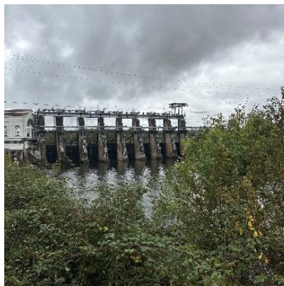
Source IGEDD Barrage de Tuilières sur la Dordogne Concession EDF
