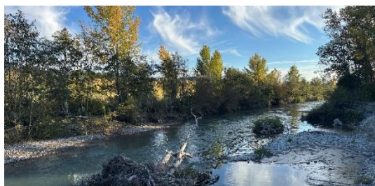
Source IGEDD Durance - Effondrement de berges lié aux atterrissements en lit mineur
