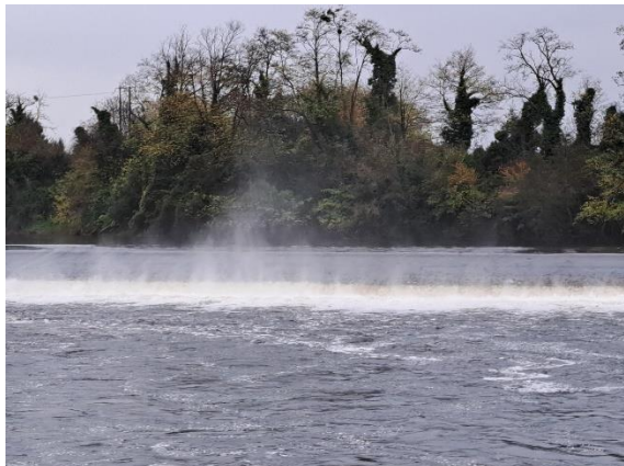
Source IGEDD - Barrage de Bergerac
