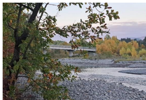
Source IGEDD - La Durance Confluence du Sasse à Sisteron
