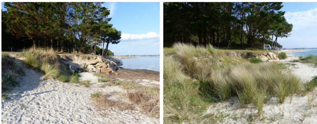
Progression de la dune blanche - extrait de l'OPP technique 2021 et 2025, source : dossier de candidature, dossier complémentaire dans le cadre de la visite d'inspection générale du 17 au 19 juin 2025.
