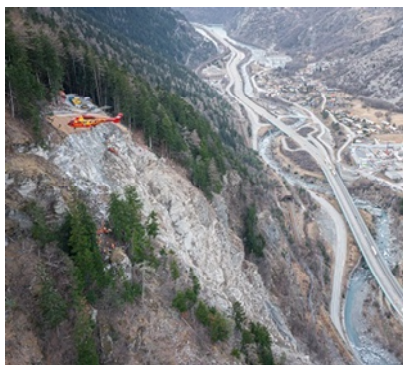
Éboulement de la Praz © Igedd
