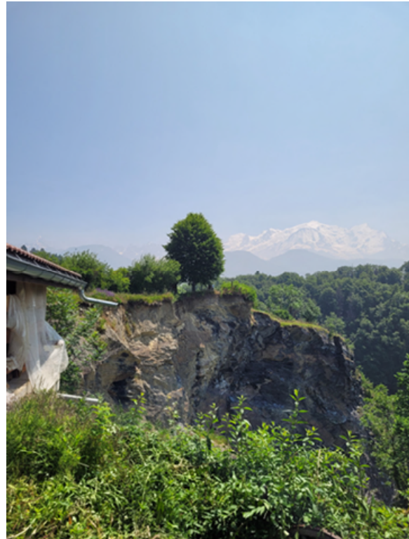
Figure 6 : Passy – hameau des Julliards – glissement de terrain (photo mission)
