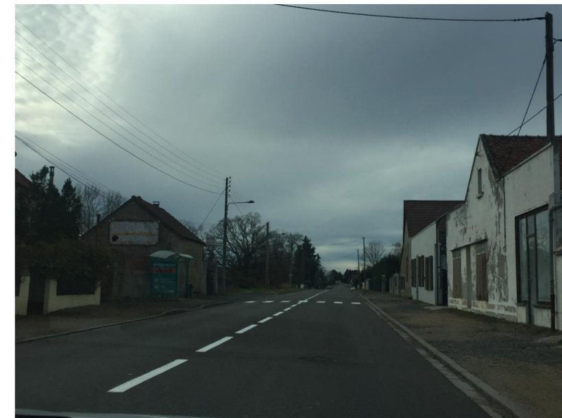
Figure 17 : RD2209 – traversée de Cognat-Lyonne (photo setec)
