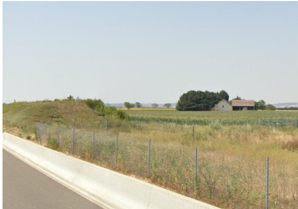
Figure 29 : Merlon acoustique réalisé au droit de la Ferme Banelle (© Egis / B. Desille, 2020)
