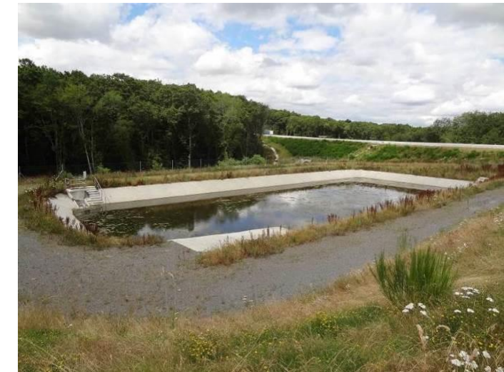
Figure 18 : Bassin multifonction BR222 mono-corps (© Egis / A.S. Chaudat, 2016)
