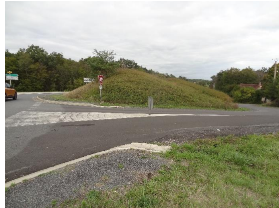
Figure 30 : Merlon réalisé au droit de Maison Blanche (© Egis / D. Ferreira, 2020)
