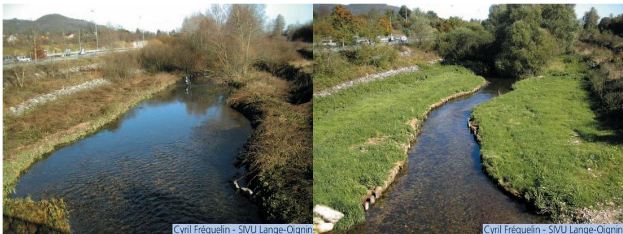
Figure 19. Exemple de restauration morphologique d'un cours d'eau par aménagement d'un chenal d'étiage sinueux (le Lange dans le département de l'Ain, avant et après restauration. Source : Onema, nov. 2012 https://professionnels.ofb.fr/sites/default/files/26_3_rex_r6_lange_vbat.pdf )
