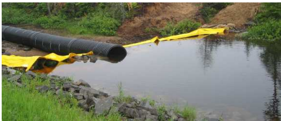
Figure 4 : Exemple de travaux de franchissement de cours d'eau en ensouillage (étude d'impact, partie I, page 24)
