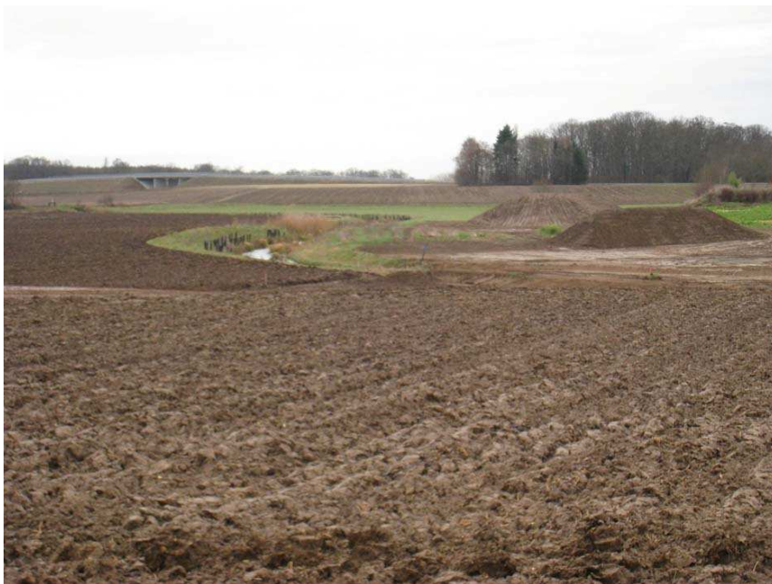
Travaux de la digue de protection en cours (photo des rapporteurs)
