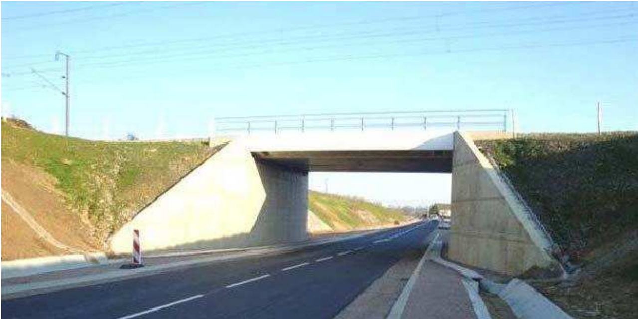
Exemple de pont-rails de 4,40 m de hauteur de passage (Source : étude d'impact)
