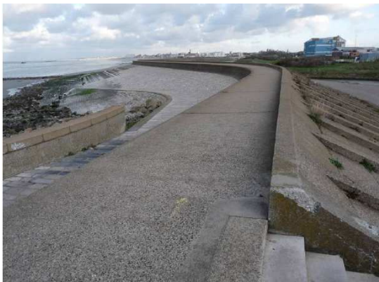
Photo de la digue côté Ouest
