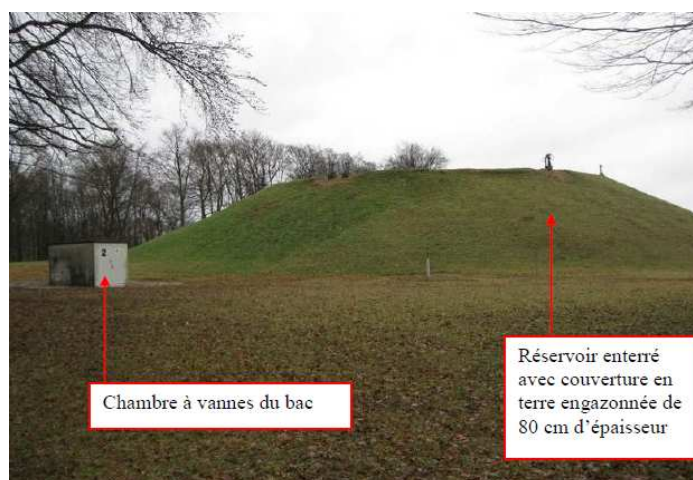
Vue extérieure d'un réservoir semi-enterré
