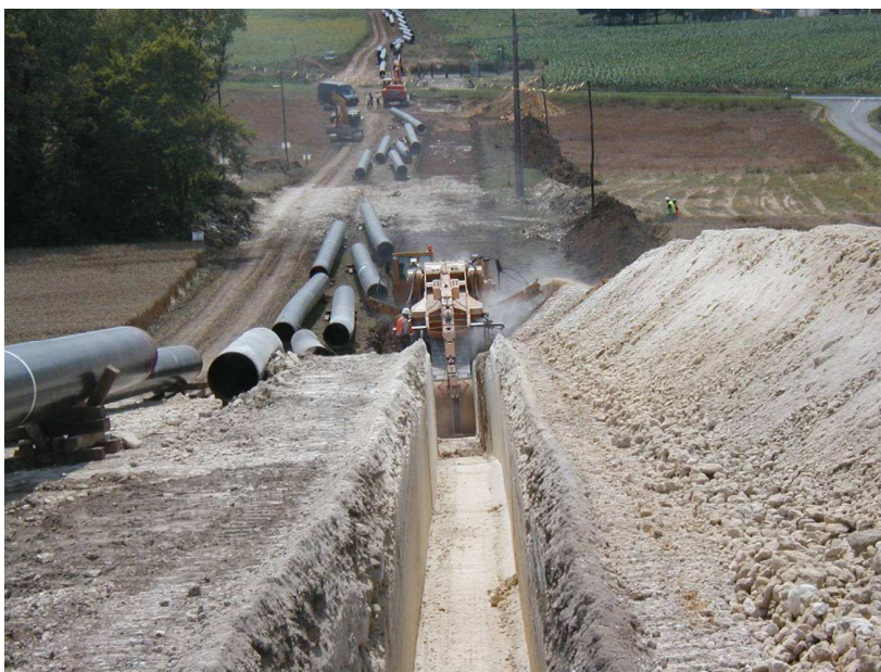
Figure 5 - Chantier de pose d'une canalisation
