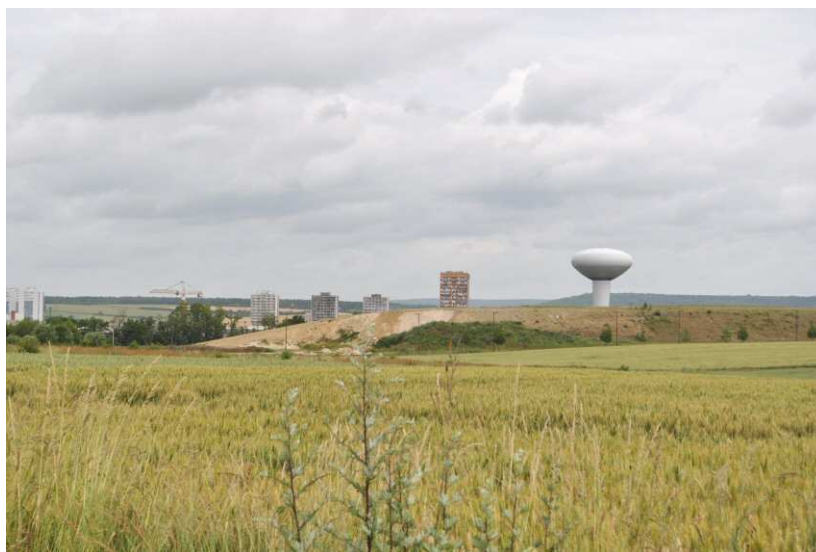
Remblais constatés sur le site, consécutifs aux travaux de la plateforme ferroviaire
