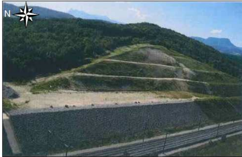
Le déblai des Ayasses vu depuis le Km 520.614 (passage à faune)
