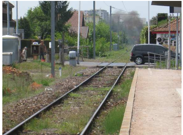
Le passage à niveau de la rue de l'Helvétie.
