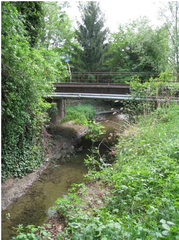
La voie ferrée actuelle franchit le Foron.
