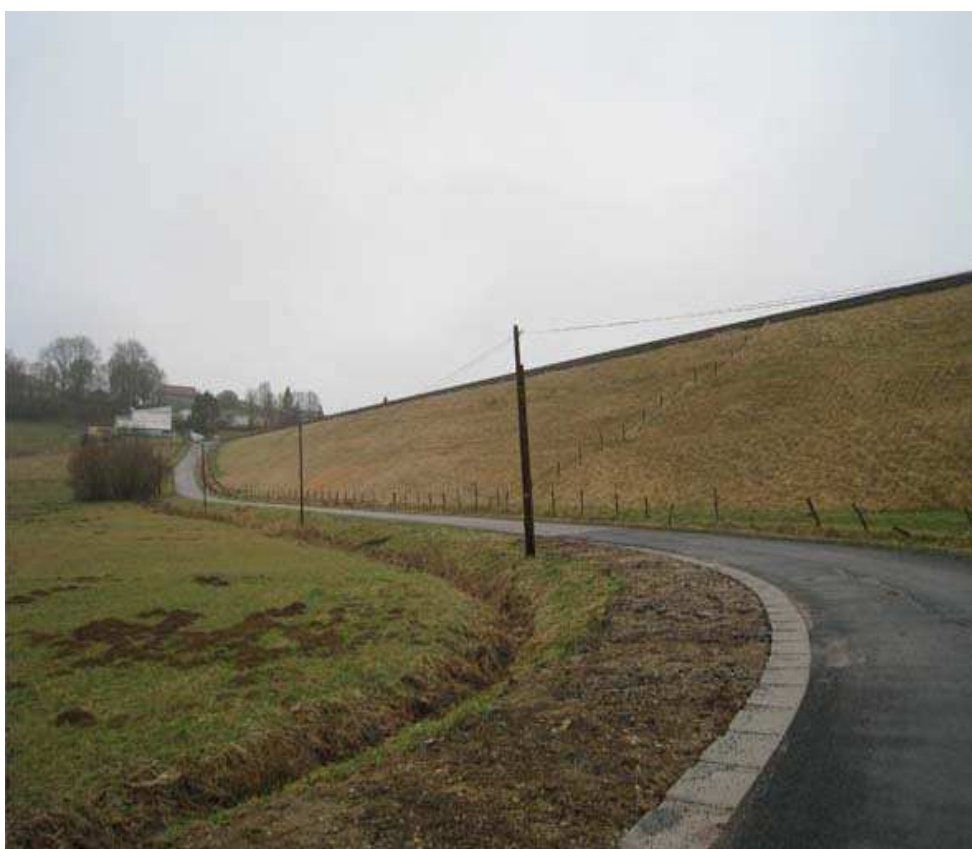
Le talus aval de la digue en terre, à recharger en remblai drainant.
