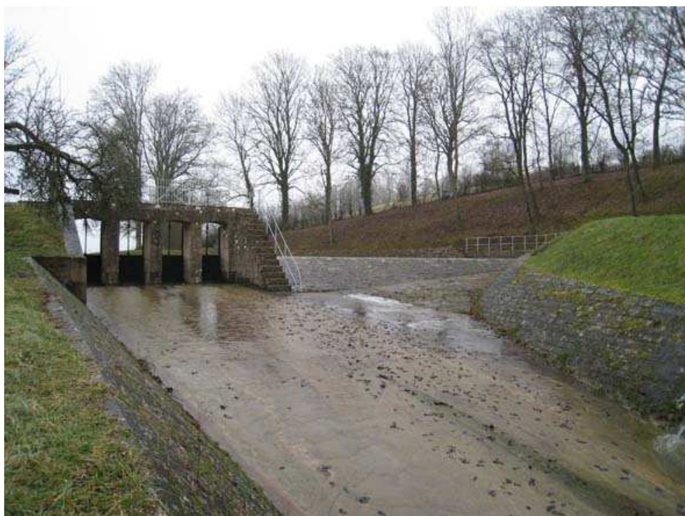
Les quatre vannes à reconstruire, le seuil libre à transformer en seuil labyrinthe (vue aval).
