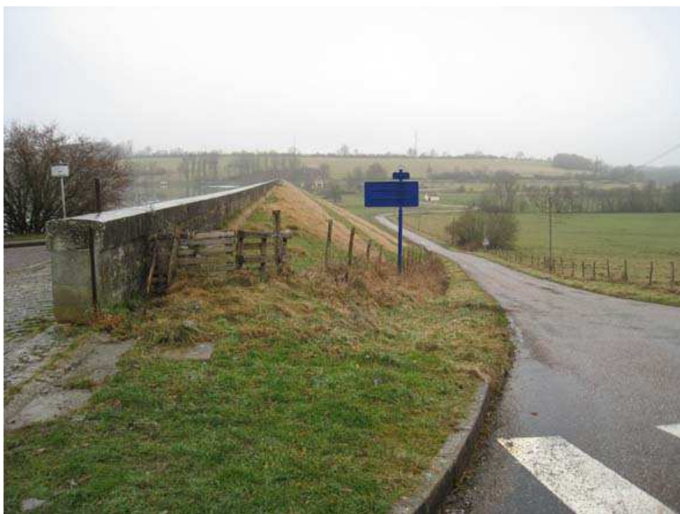
Le talus aval de la digue en terre, à recharger en remblai drainant.
