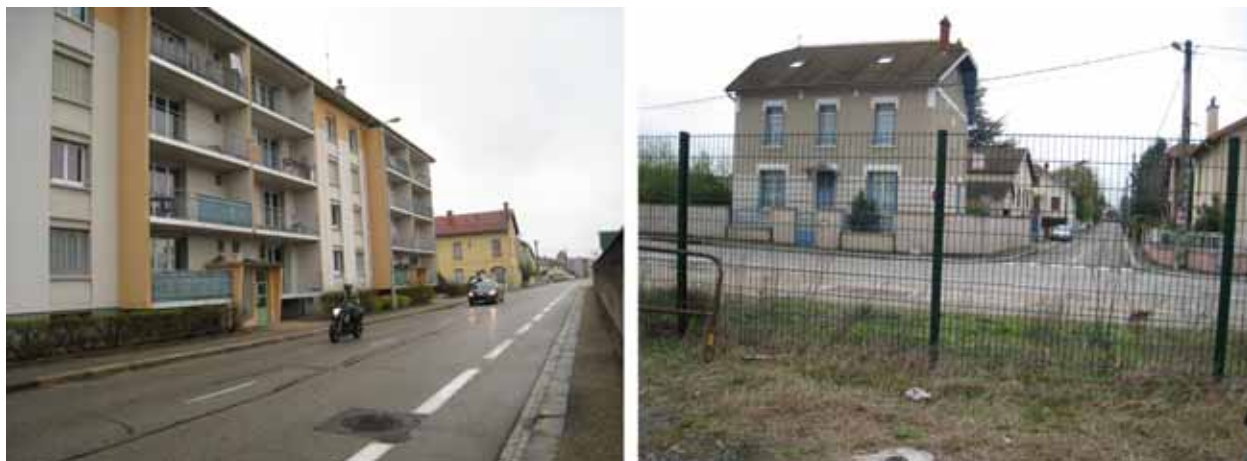
rue du Peloux : habitations proches du chantier
