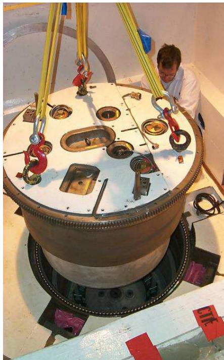
Vue de la cuve, bouchon tournant retiré, faisant apparaître l'empilement des dalles de protection biologique. Au centre de la cuve, la couronne qui recevait les éléments de combustible.
