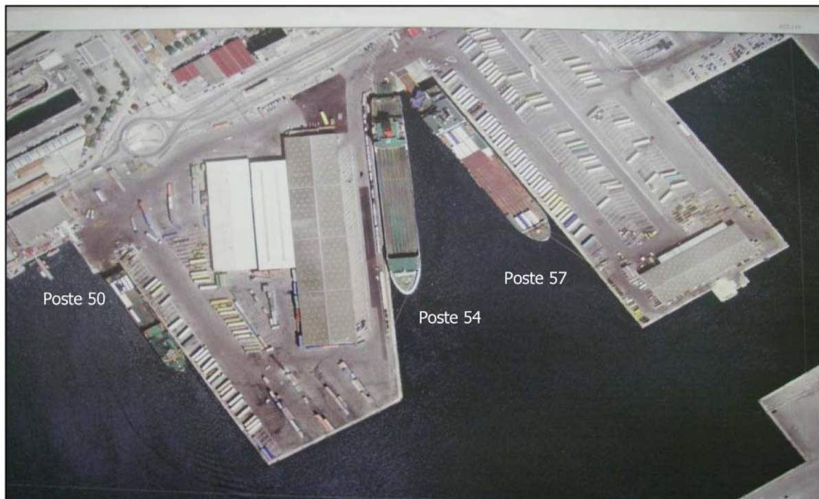
Vue aérienne d'une partie du Terminal Roulier Sud au niveau des postes 50, 54 et 57
